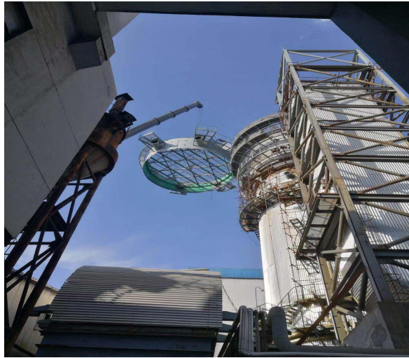
项目超净脱硫塔改造中
